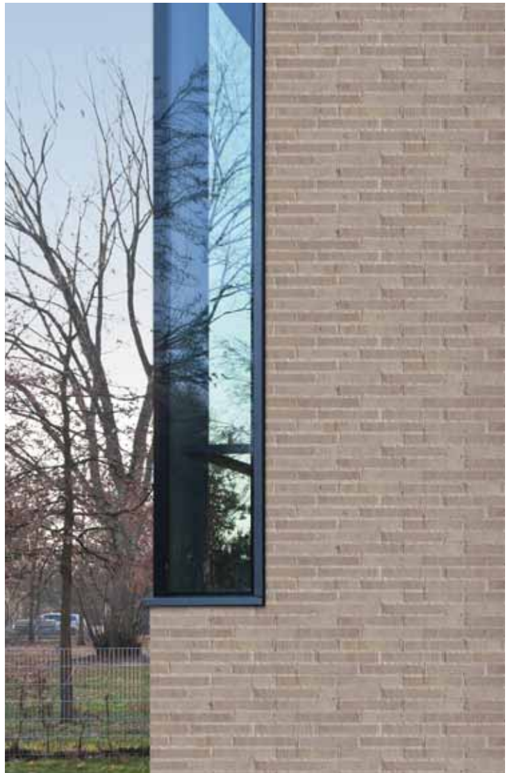
36102 aquaterra Vesuvgrau 365 x 115 x 52 mm Fugmörtel + heller Splitt, Körnung 1,8-3 mm
